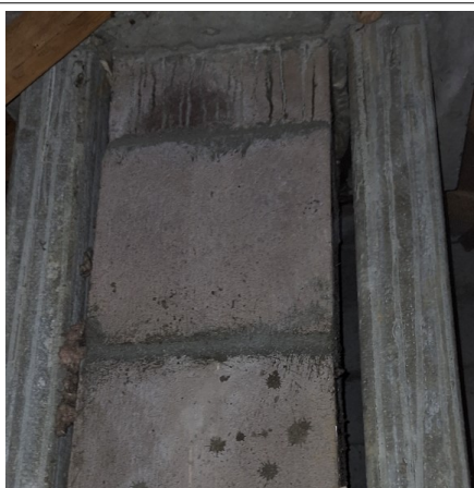
prélevé - idem P013 : 1 er étage / Comble - Conduit- (Présence d'amiante)
