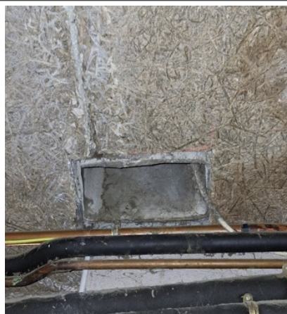
Prélèvement - P023 : RDC / Garage - Conduit- (Présence d'amiante)
