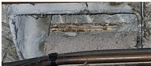
Prélèvement - P043 : RDC / Garage - Conduit- (Présence d'amiante)
