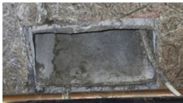
Déclaré - : RDC / Garage - Conduit- (Présence d'amiante)
