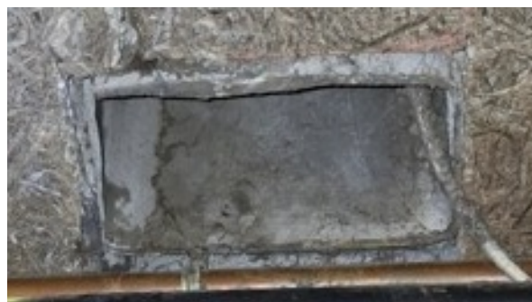
Déclaré - : RDC / Garage - Conduit- (Présence d'amiante)
