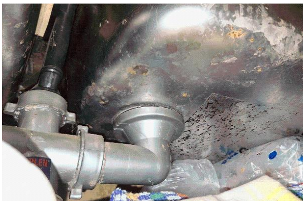
Déclaré - : RDC / Cuisine - Plaque bitumineuse- (Absence d'amiante)
