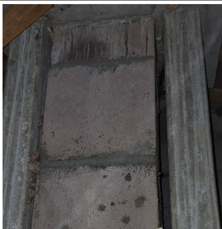
déclaré - : 1 er étage / Comble - Conduit- (Présence d'amiante)
