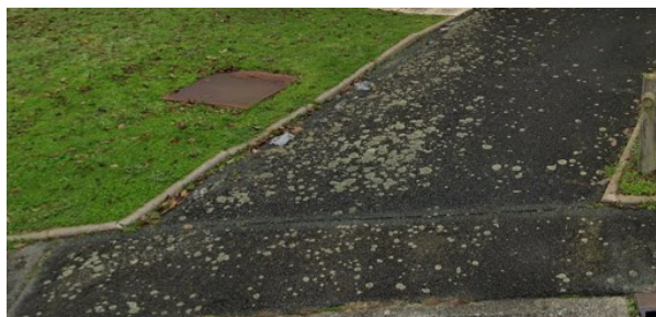
Prélèvement - P012 : Extérieur / Voirie - Enrobé bitumineux- (Absence d'amiante)
