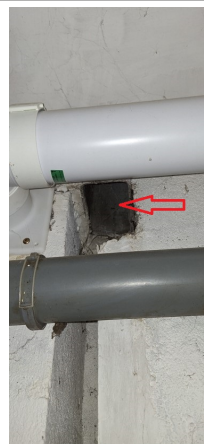
Prélèvement - P035 : RDC / Garage - Conduit- (Présence d'amiante)
