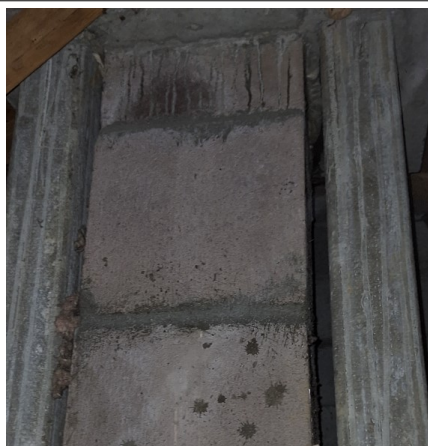
prélevé - idem P006 : 2 eme étage / Comble - Conduit- (Présence d'amiante)
