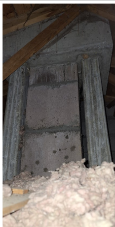
Prélèvement - P020 : 1 er étage / Comble - Isolant- (Absence d'amiante)
