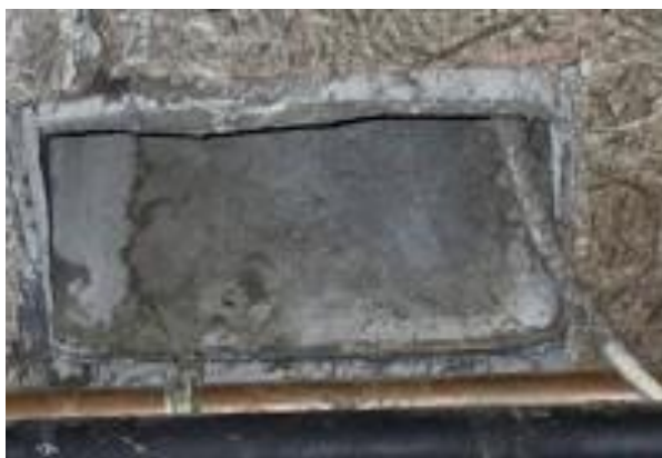
Déclaré - : RDC / Garage - Conduit- (Présence d'amiante)
