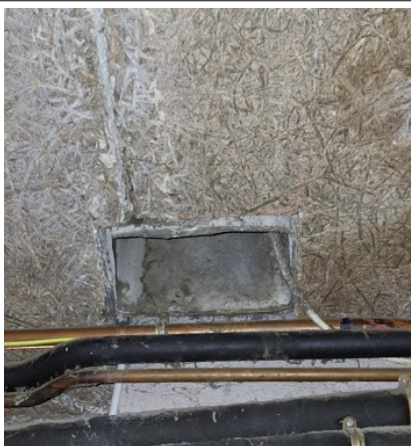
Prélèvement - P006 : RDC / Garage - Conduit- (Présence d'amiante)
