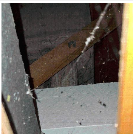
déclaré - : 1 er étage / Comble - Conduit- (Présence d'amiante)
