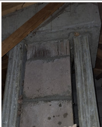
prélevé - idem P011 : 2 eme étage / Comble - Conduit- (Présence d'amiante)
