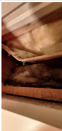
Prélèvement - P032 : 1 er étage / Comble - Isolant- (Absence d'amiante)
