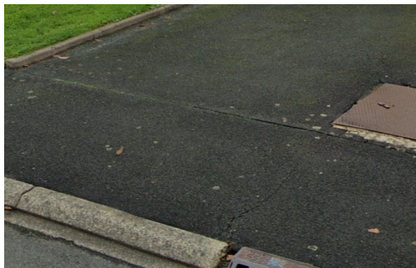
Prélèvement - P034 : Extérieur / Voirie - Enrobé bitumineux- (Absence d'amiante)
