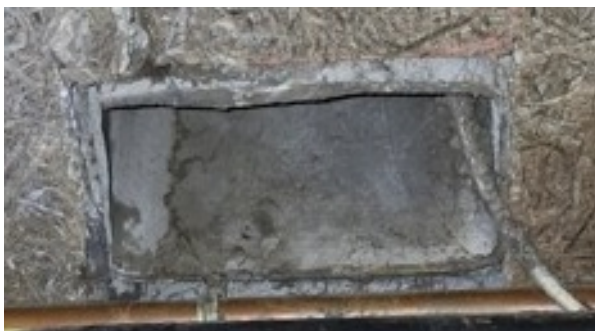
Déclaré - : RDC / Garage - Conduit- (Présence d'amiante)
