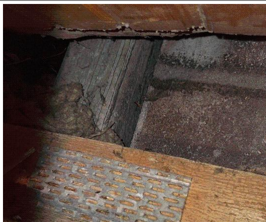
déclaré - : 2 eme étage / Comble - Conduit- (Présence d'amiante)
