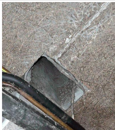
Prélèvement - P011 : RDC / Garage - Conduit- (Présence d'amiante)
