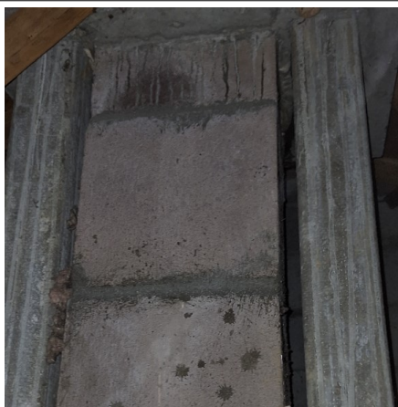
prélevé - idem P035 : 1 er étage / Comble - Conduit- (Présence d'amiante)
