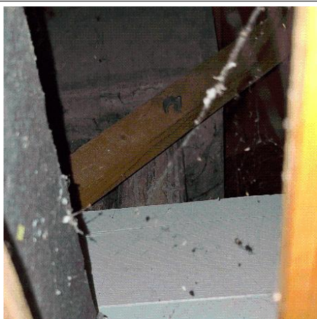
déclaré - : 1 er étage / Comble - Conduit- (Présence d'amiante)
