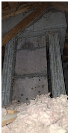
prélevé - idem P023 : 1 er étage / Comble - Conduit- (Présence d'amiante)
